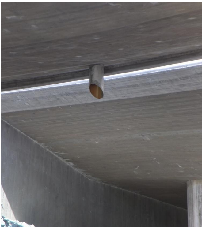
E16 Agnes bru, Vøyenenga. Overflatevann fra E16 går i steinfylling i flomsone til Sandvikselva. Men en steinfylling er ikke noe rensedbasseng. Veivannet bør gå til nærliggende rensedbasseng ved Lommedalskrysset.
