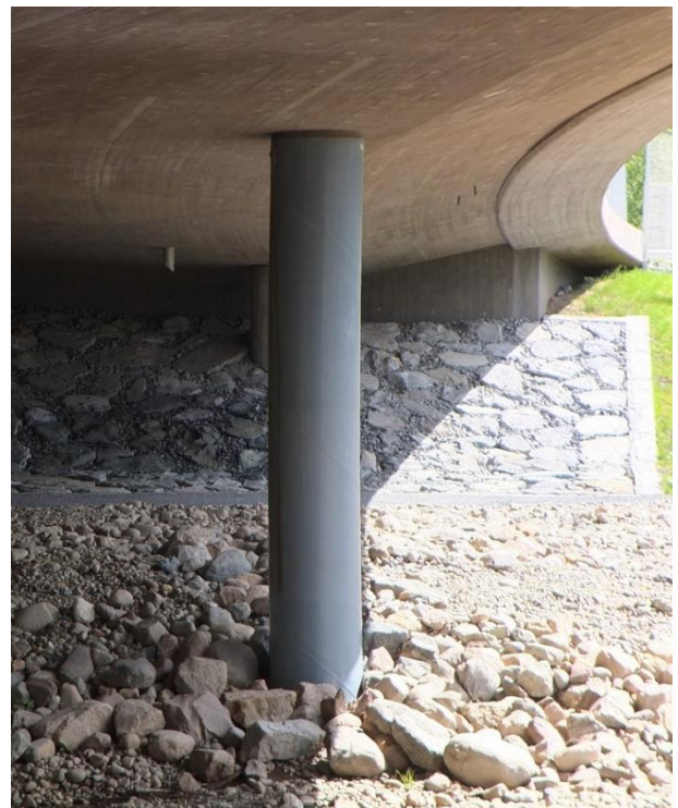
E16 Agnes bru, Vøyenenga. Overflatevann fra E16 går i steinfylling i flomsone til Sandvikselva. Men en steinfylling er ikke noe rensedbasseng. Veivannet bør gå til nærliggende rensedbasseng ved Lommedalskrysset.
