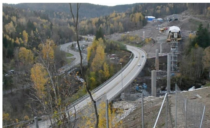
Innelukket «støpe fabrikk» er brukt for bygging av de to nye Bjørum Sag broene.
