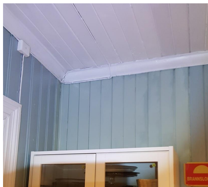
Renovert hjørne i kjøkkenet før og etter utskifting av panel og malt. Foto Per Håkon Nervold
