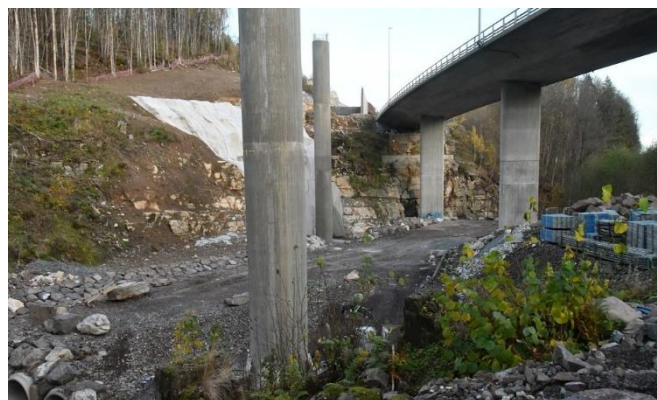
Ny E16 bro ved Bjørum Sag. Isielva er lagt i tre store rør under bygging av to nye broer og rivning av E16 broen fra 2009.
