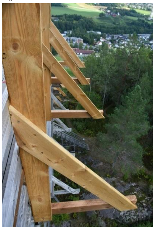
Over: Utvendig støttebjelke med gjennomgående bolter er byttet ut. Under: Utkrager og skråstøtter for rekkverk er skiftet
