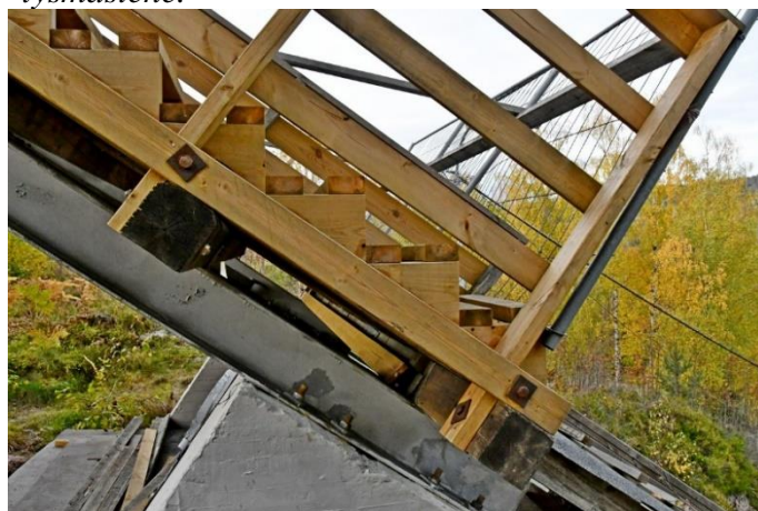
Over: Utvendig støttebjelke med gjennomgående bolter er byttet ut. Under: Utkrager og skråstøtter for rekkverk er skiftet
