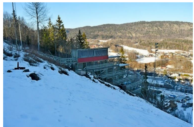
Ikke bare de store granene nord for hoppet, men også store graner og tørrgraner som truet tribuner, flomlysanlegg og kraftledningen nord for tribunen, er fjernet
