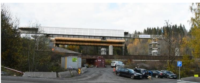
Innelukket «støpe fabrikk» er brukt for bygging av de to nye Bjørum Sag broene.
