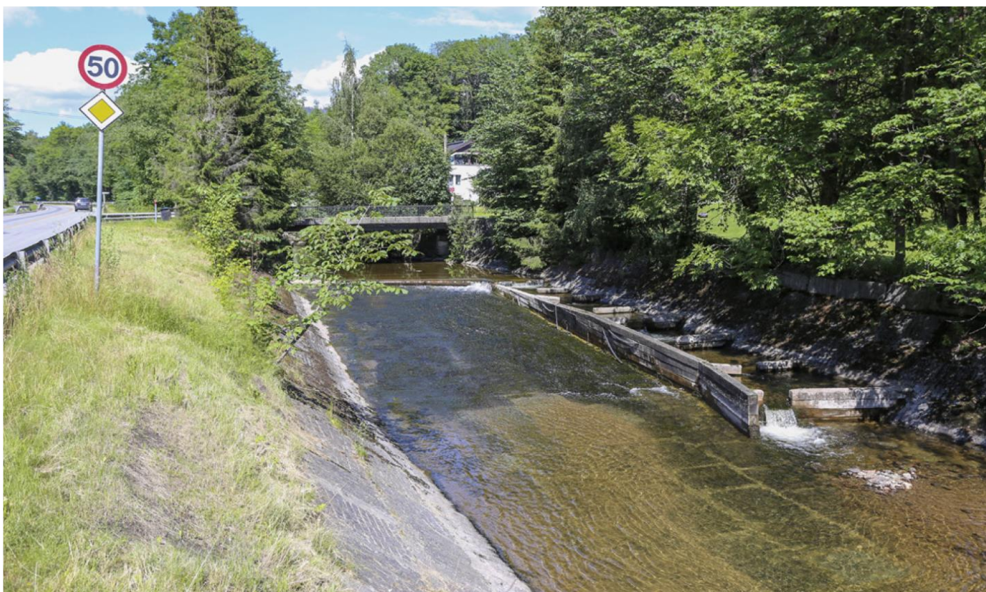
100 m ovenfor Nybrua lå «Lille Sand teinested» til Martin Sølvhølen som eide Lille Sand fra 1925 til 1937. Fisket her var dog ikke like godt som Kalveløkka teinested nedenfor. Her er det bygd laksetrapp for at fisken ikke skal skade seg på de skarpe larvikittplatene som er lagt ut for å beskytte vannledningene under.
