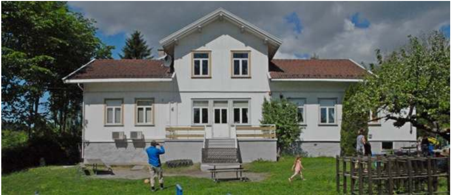
Berghoff, Skui Vels gamle forsamlingshus og Berghoff barnehage. Bygget før 1900.
