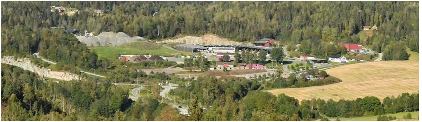
Isi miljøstasjon sett fra syd. E16 nederst til venstre. Miljøstasjon midt i bildet. Østlandsjord med storesteindeponier øverst til venstre.
