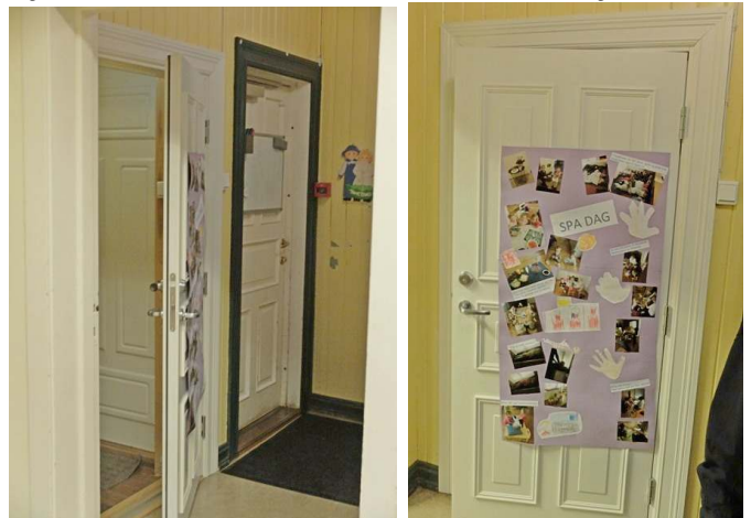
Ny brannør til trappoppgang 2. etasje er installert
