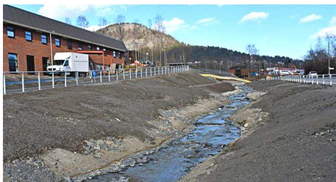
Dælibekken nye buktende løp langs Rud. Bekkesidene skal beplantes med busker og trær
