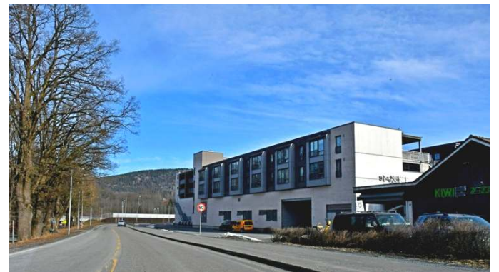
Varelevering foregår på nordsiden av senteret. Her er smalt og trangt og bilene må rygge inn/ut da de ikke kan snu. Det trengs en løsning som ikke blander trafikken med personbiltrafikk til senteret fra Skuivein som medfører daglige nesten ulykker.
