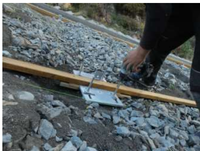
Vangen bygges med trykkimpregnerte lekter og festes til de svilleplatene.
