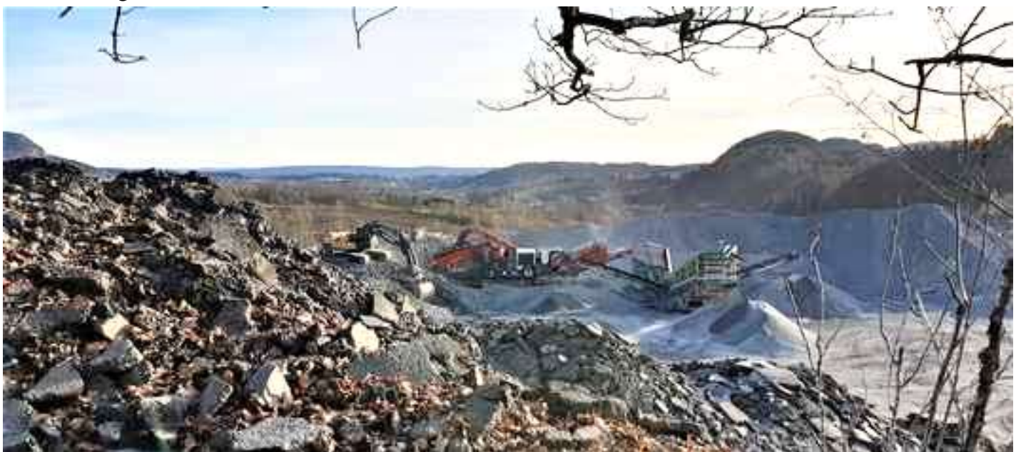
Østlandsjords knuservirksomhet på Isi. Sprengstein, asfalt og betong. Åpent utsyn over hele Skuidalen, Kirkerud og Tanumåsen i bakgrunnen midt i bildet. Svartoråsen til høyre. Foto Johannes Mylius
