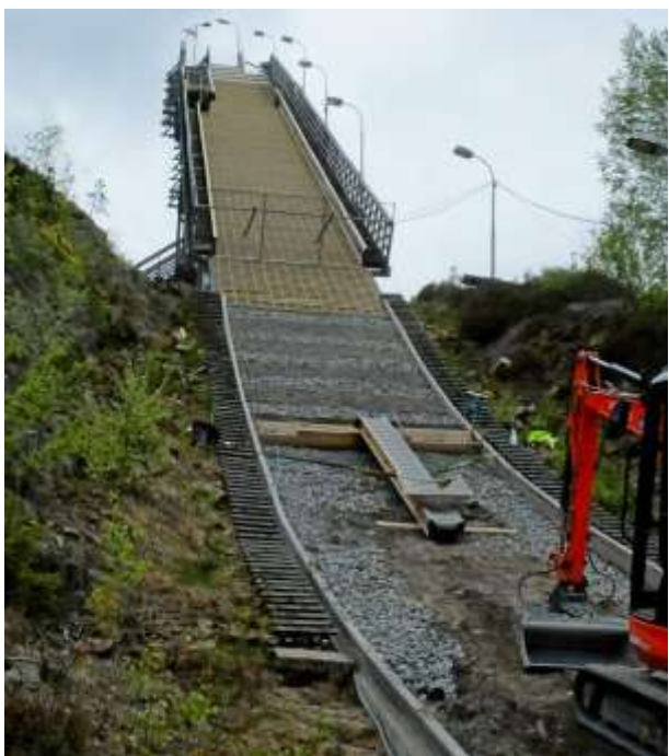
Ny papp lekter og sløyfer skiftet. Erosjonsikring av tilløpet med oppsamlingsrenne ig drensør langs vangen og pukk.
