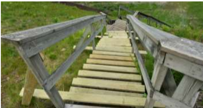
Utbedre trapp på sørsiden pga økt slitasje da Corona restriksjoner ga økt uteaktivitet
