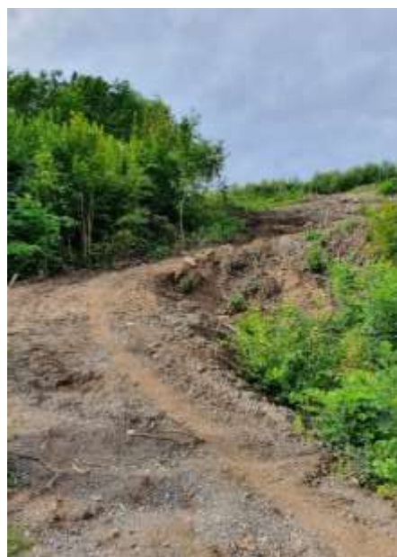
Fra svingen i Tunheimbakken er det etablert en anleggsvei opp skråningen.
