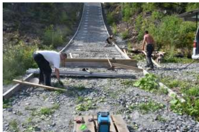
Autofendre er brukt som sviller og egendesignet og produserte svilleplater for å feste vangen monteres.
