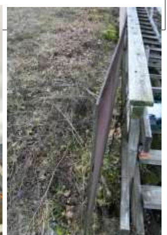
Vantplater ble skrudd og festet på nytt
