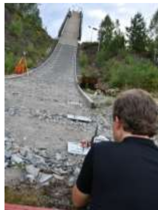
Innmåling med laser og bruk av 3D-terrengmodell for sikre jevn og rett kurve. Justering etterpå. Mye konstruksjon og montering arbeid som ble gjort på dugnad.
