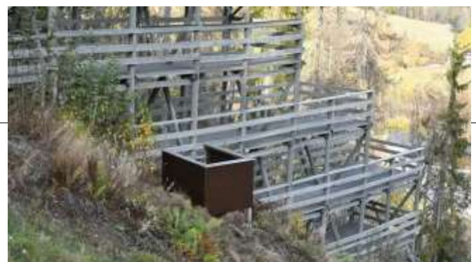
Rennlederboxen foran kongtribunen. Dekkplater skiftet ut med tilsvarende, vann og råtesikre plater.
