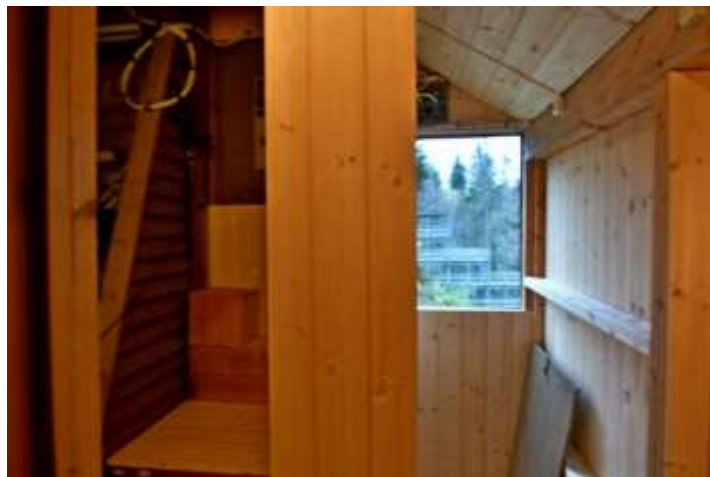
Rennleders plass var til venstre og dommer A til høyre. Yttervegg på eldste byggetrinn synes til venstre.
