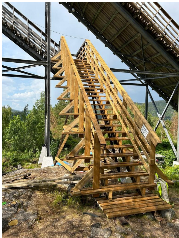
Adkomstrappen til fartsstillaset er fornyet, trappetrinn og rekkverk mv er skiftet ut.
