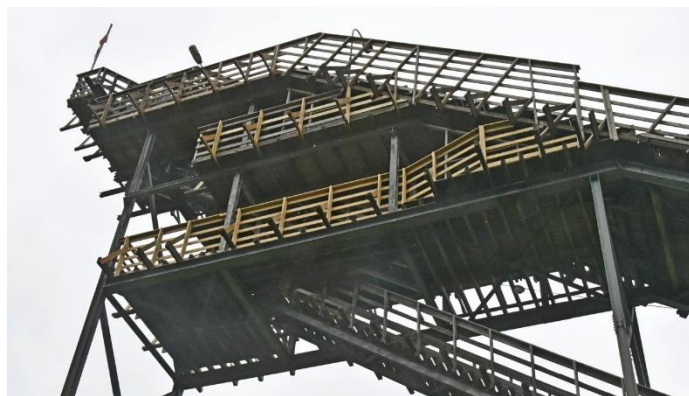
Rekkverk og støtter på avsatter mot syd er skiftet ut.
