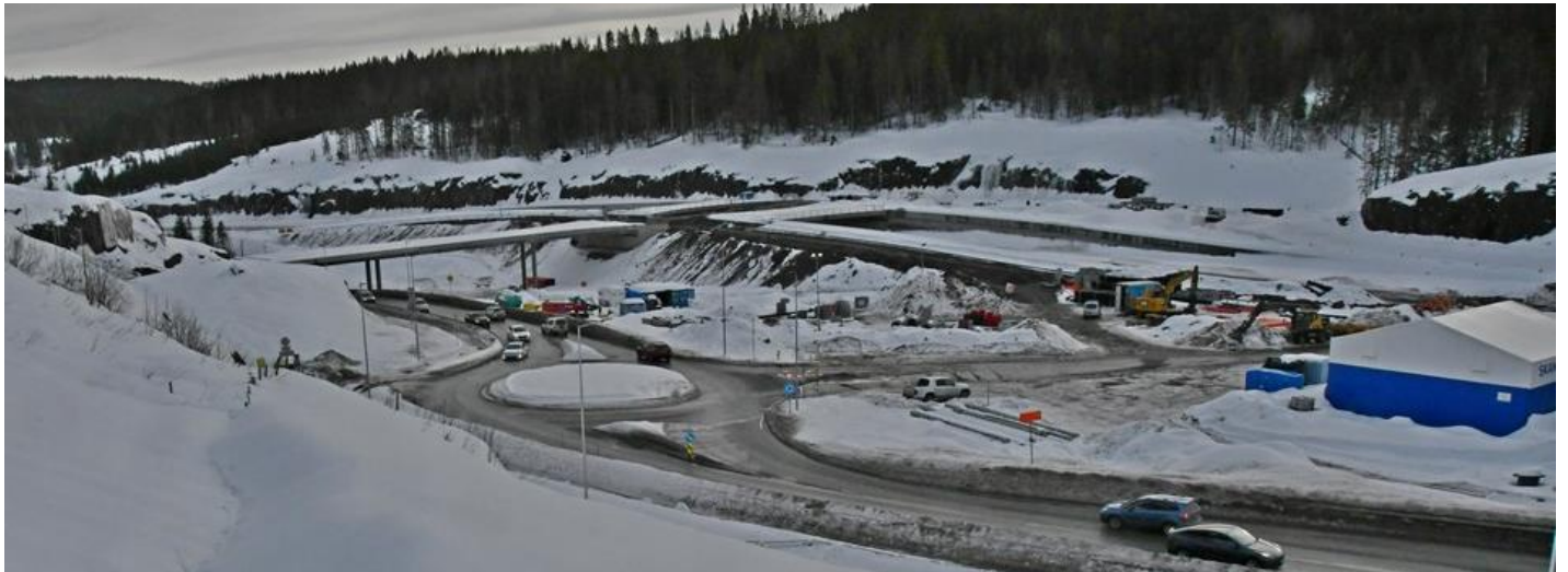
E16 Avtjernakrysset sett mot vest
