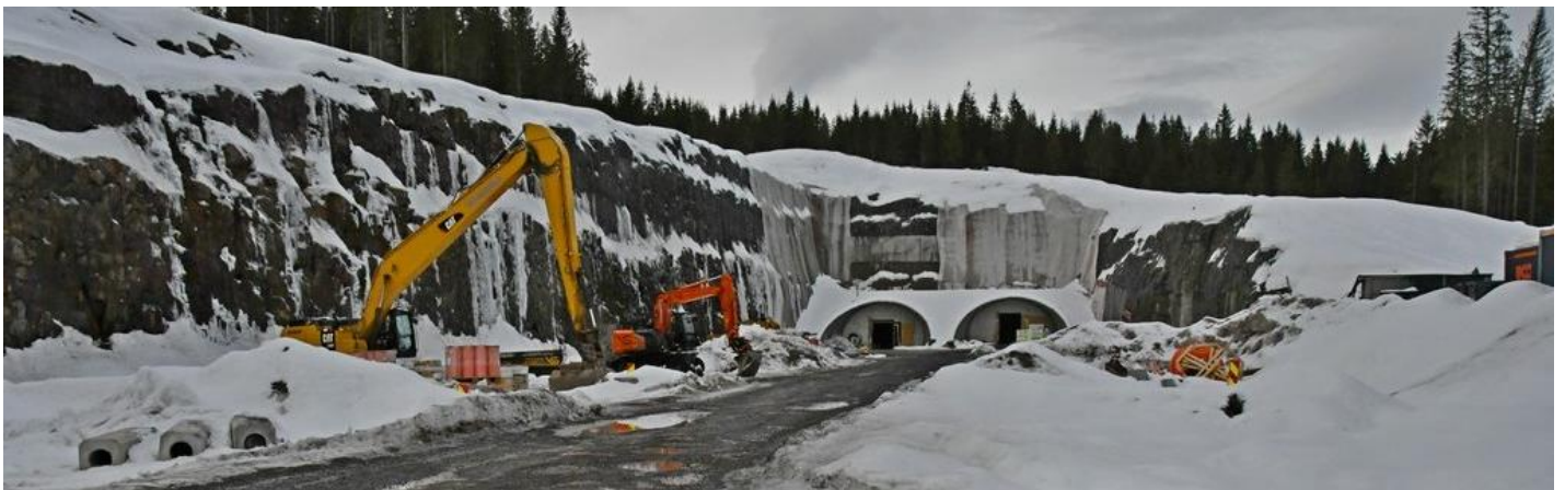
E16 Tunnelinnslaget for Sollihøgdatunnelen nordover.
