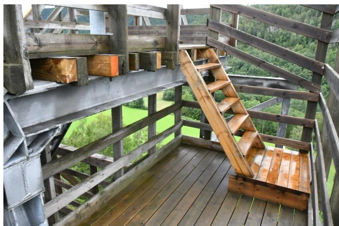
Adkomstrappen fra toppen til neste avsats er fornyet
