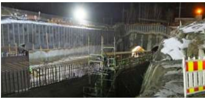
E16 bygging av Franzefoss kulverten
