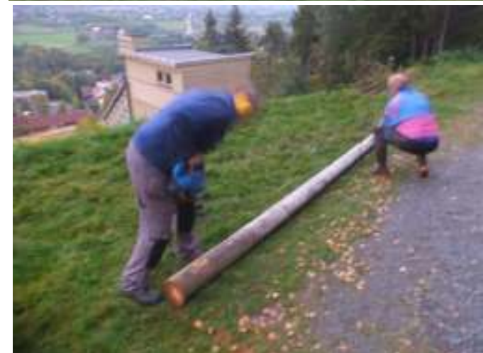
Impregnerte tømmerstokker er lagt ut og festet til grunnen for å hindre billkjøring på grøntområde og på sletta og i overgangen.
