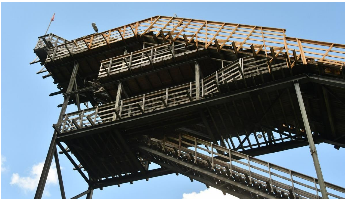
Rekkverk, utvendig langsgående støttebjelke og trapper langs tilløpet var dårlig og usikkert og er skiftet ut.
